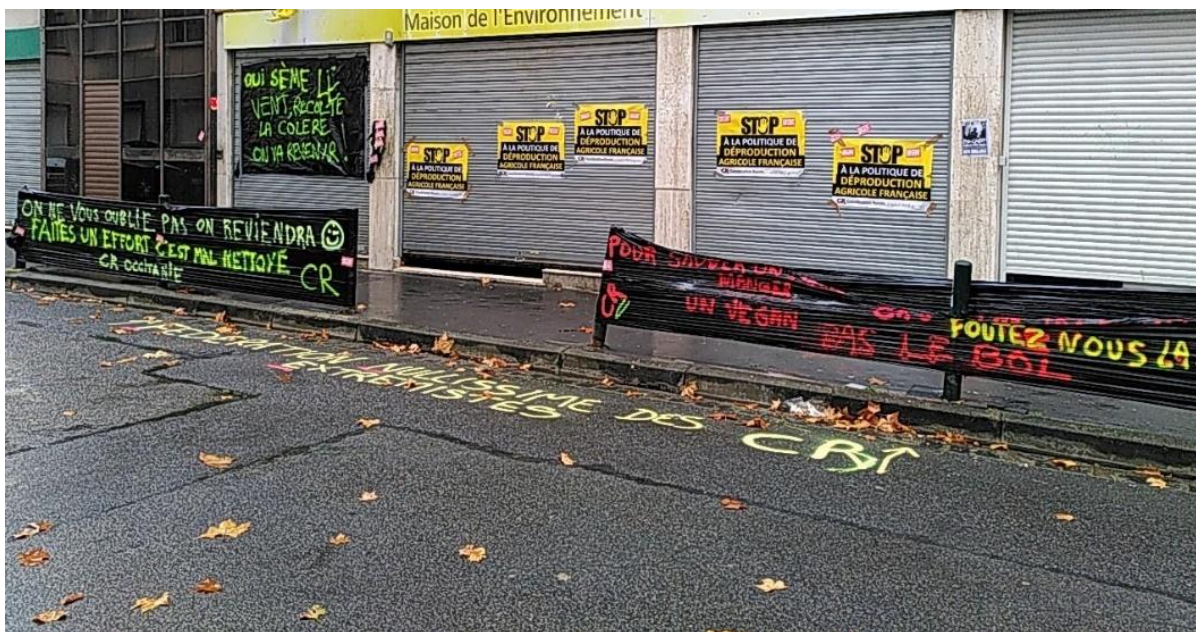
Dégradation Maison de l'Environnement, Toulouse
