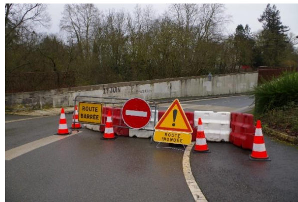
Mise en place de déviations
