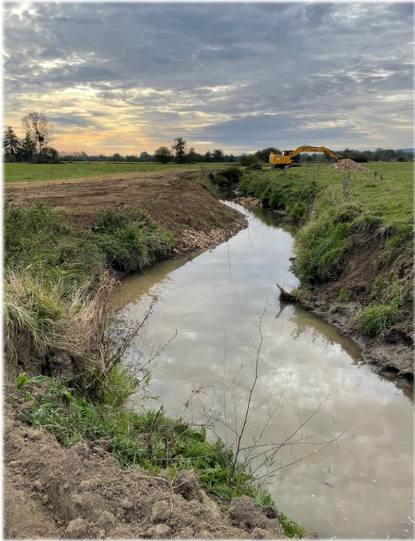
Basses eaux « pendant » travaux Octobre 2023
